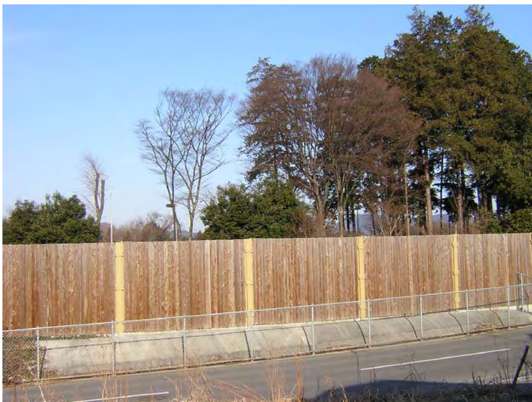
(間伐材を活用した木製遮音壁／東北自動車道上り・大谷パーキングエリア)
